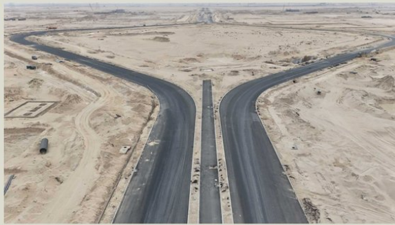
جانب من أعمال البنية التحتية في جنوب صباح الأحمد
